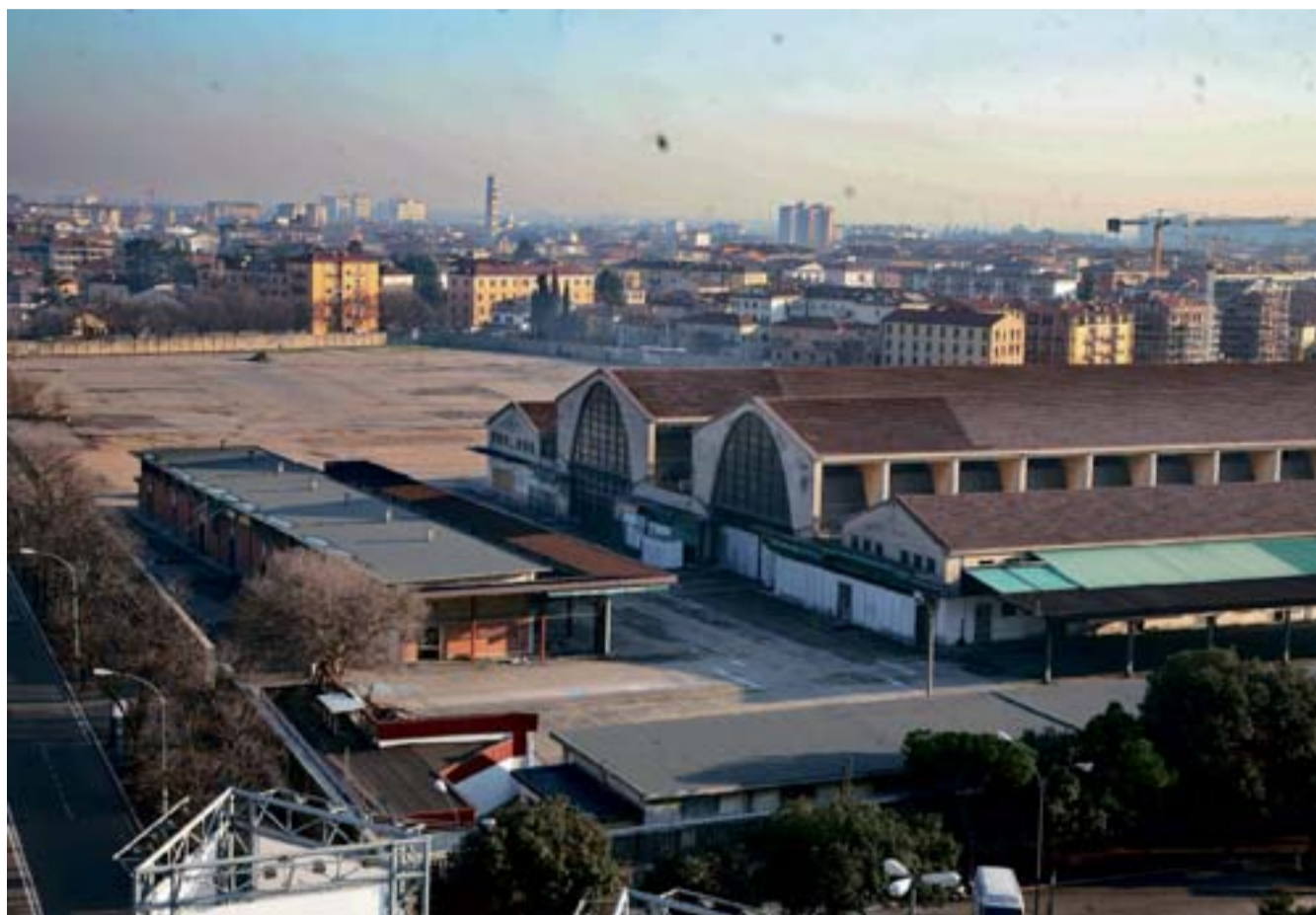
Verona sud: tra l'area dell'ex Mercato ortofrutticolo e le case sullo sfondo, sorgeranno gli edifici e il parco previsti nel Prusst FOTO MARCHIORI
