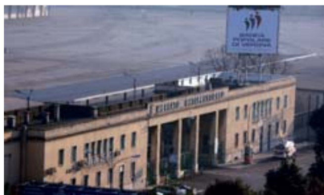
L'ingresso del vecchio Mercato di fronte alla Fiera
