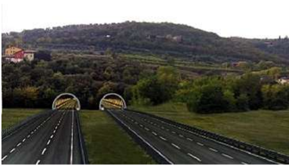
L'ingresso in galleria del passante delle Torricelle nella parte est, alla Ca' Rossa di Poiano
